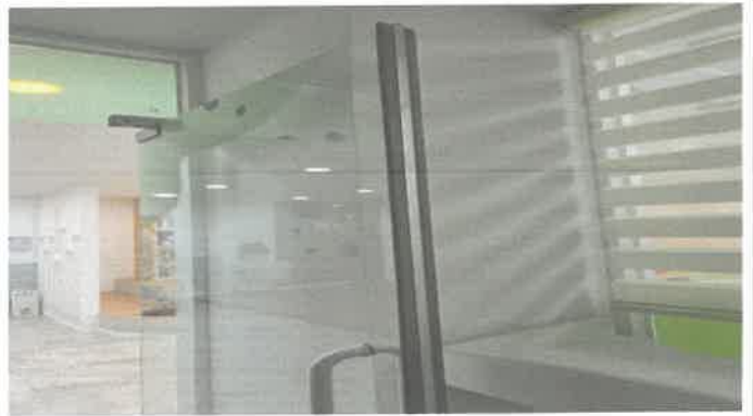
1층 온스터디 강화문 안전리브 설치
