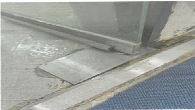
수영장 남자샤워실 출입문 하부힌지 교체
