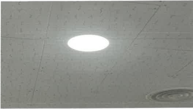
3층 남자화장실 다운라이트 1구 교체
